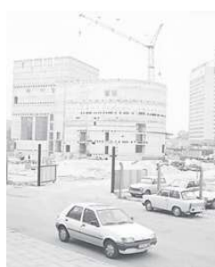
Blick auf die Baustelle mit dem Interhotel im Hintergrund von Fotograf Werner Taag.
